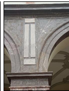
Fig. 2A, B. Loggia frontowa zdobiąca fasadę budynku – wykorzystanie zlepieńców zygmontowskich (kolumny – część zewnętrzna) oraz wapieni bolechowickich (kolumny – część wewnętrzna, sklepienia łuków między filarami, tralki i balustrada). Dodatkowo pasy z czarnego, użyłonego kalcytem, wapienia „Ołowianka” (1C) oraz beżowego wapienia „Szewce” (1 D), (fot. K. Guzik, A. Kot-Niewiadomska)
