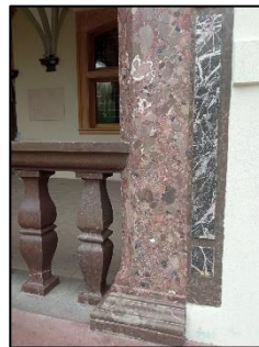
Fig. 2A, B. Loggia frontowa zdobiąca fasadę budynku – wykorzystanie zlepieńców zygmontowskich (kolumny – część zewnętrzna) oraz wapieni bolechowickich (kolumny – część wewnętrzna, sklepienia łuków między filarami, tralki i balustrada). Dodatkowo pasy z czarnego, użyłonego kalcytem, wapienia „Ołowianka” (1C) oraz beżowego wapienia „Szewce” (1 D), (fot. K. Guzik, A. Kot-Niewiadomska)
